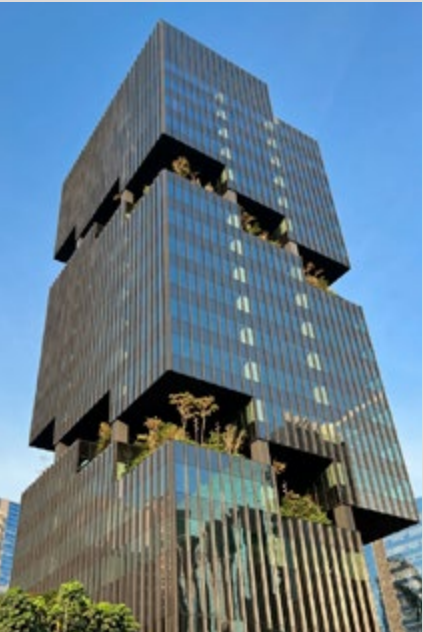
EDIFÍCIO BOSCO CORPORATE
